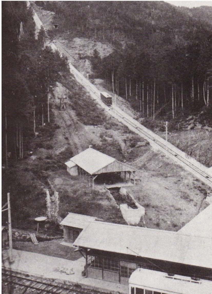
変電所でしょうか？
