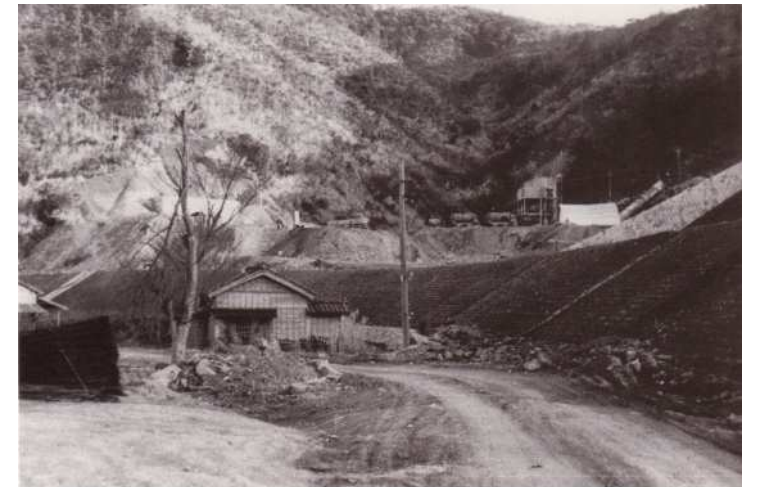
伊勢志摩スカイライン工事中 昭和39 西行谷
