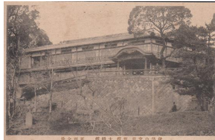
伊勢宮内前旅館大橋館 正面全景
